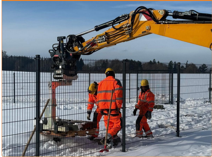
Arbeiten über Hindernisse hinweg
