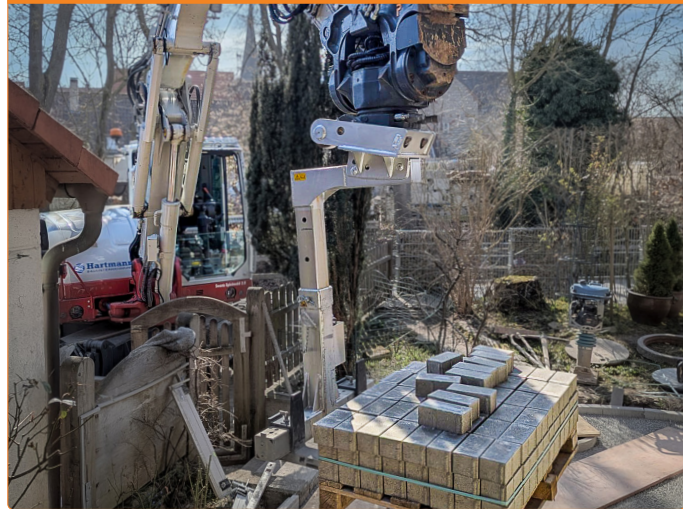
Arbeiten auf engstem Raum
